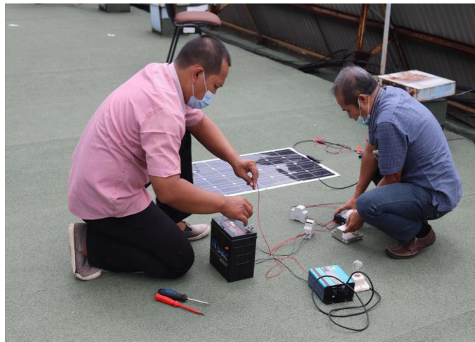
Gambar 12. Pemeriksaan kabel yang menyambungkan setiap komponen
