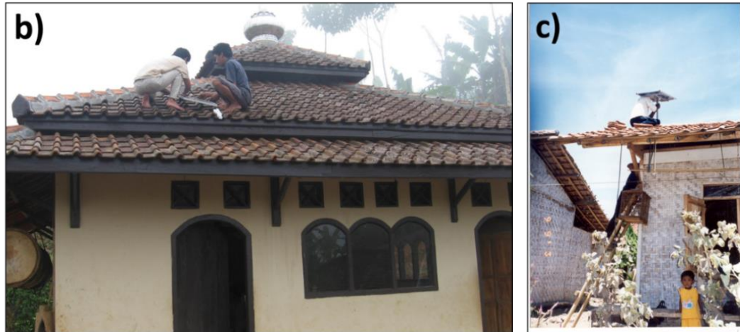
Gambar 1. Penjelasan materi kepada peserta dan contoh pemasangan panel surya (a) Penggunaan aplikasi Zoom saat penjelasan materi kepada peserta (b) Contoh pemasangan panel surya tipe off grid di tempat ibadah dan (c) Contoh pemasangan panel surya tipe off grid di rumah penduduk
