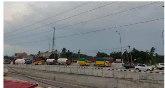
Gambar 2. Kondisi Eksisting Ruas Jalan Soekarno-Hatta
