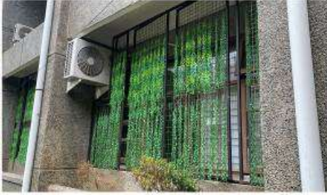
Gambar 3. Secondary skin fasad dengan tanaman artifisial
