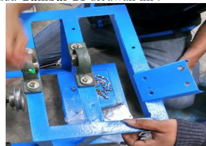
Gambar 21 Pemasangan Bearing pada rangka
