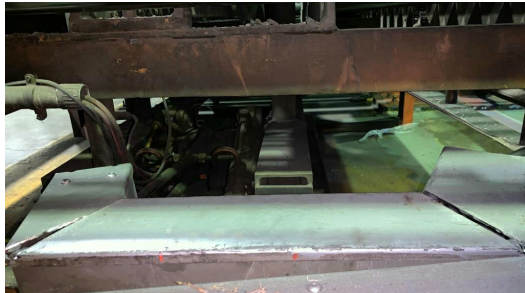
Gambar 10. Pemasangan Tray untuk melindungi Flexible Hose dari pecahan beling
