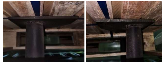
Gambar 9. Posisi plat penyangga dibagian bawah pallet sesudah perbaikan
