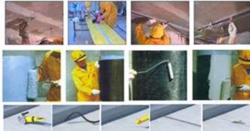
Gambar 2. Tahapan pelaksanaan pemasangan *carbon fiber reinforced polymer*
