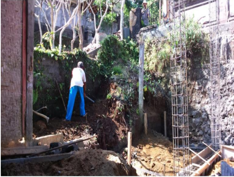
Gambar 2. Pekerjaan Galian Tanah
