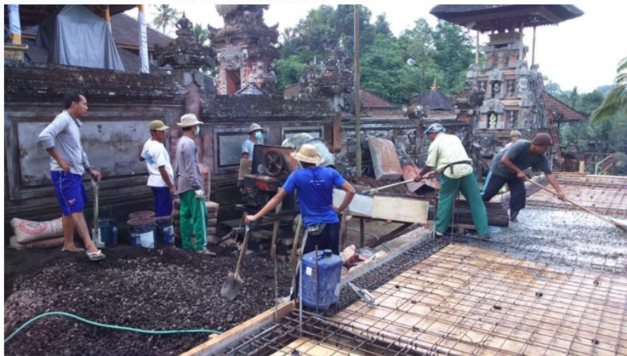
Gambar 3. Masyarakat Sedang Melakukan Kegiatan Pengecoran Beton
