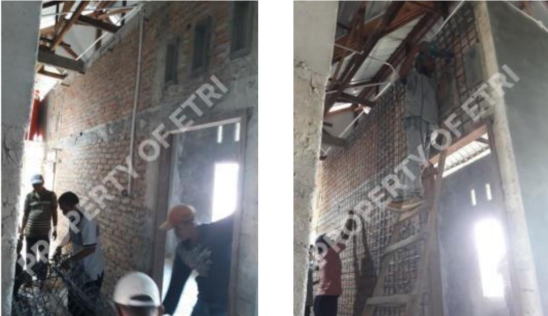
Gambar 3 Dinding bagian luar sebelum dan saat pemasangan tali ppbm (dok.pribadi)
