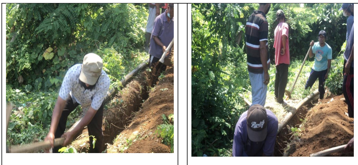
Gambar 1. Pelaksanaan Instalasi Pergantian Pipa
