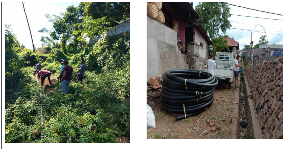
Gambar 3. Pemasangan Instalasi Dekat Saluran Air di Jalan Raya Utama
