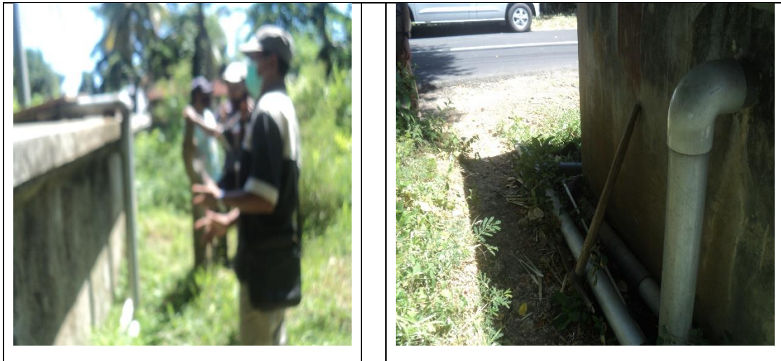
Gambar 2. Hasil Perbaikan Di Bak Penampungan
