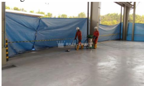
Gambar 3. Pembersihan Lantai dari Debu
