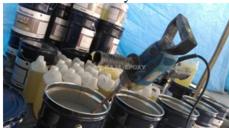
Gambar 5. Pelapisan Lantai dengan Cat Epoxy
