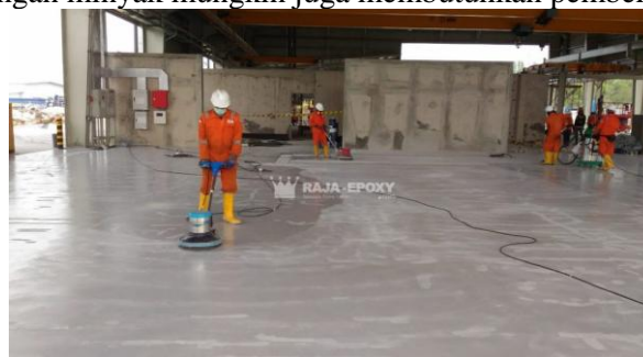
Gambar 2. Persiapan Permukaan
