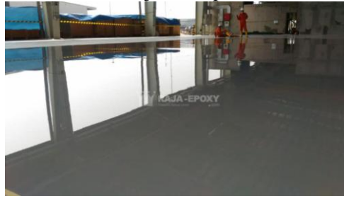
Gambar 7. Pelapisan Terakhir
