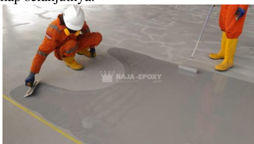
Gambar 4. Pelapisan Lantai dengan Cat Primer
