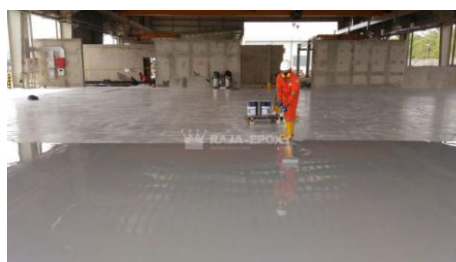
Gambar 6. Pelapisan Cat Epoxy dengan Roller
