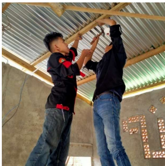
Gambar 3. Proses perbaikan dan penataan ulang instalasi listrik Musholla Al-Barkah
