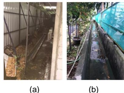
Gambar 12. (a) Saluran air hujan (b) Saluran U-Ditch untuk drainase kota
