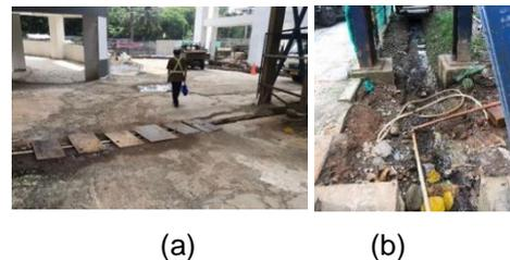
Gambar 11. (a) area untuk pembersih roda transportasi (b) *sump pit* untuk pengendapan tanah
