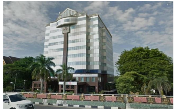
Gambar 2. Gedung Pemandang PT Surya Dumai
