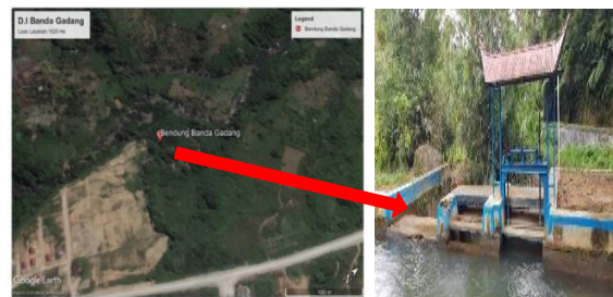
Gambar 2 Lokasi Bendung Banda Gadang
