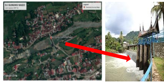
Gambar 1 Lokasi Bendung Gunung Nago
