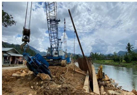
Gambar 2. Proses perbaikan pada ruas jalan KM.45+400
