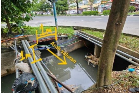
Gambar 3. Dimensi saluran eksisting Jalan Pembangunan
