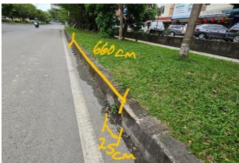
Gambar 4. Inlet saluran
