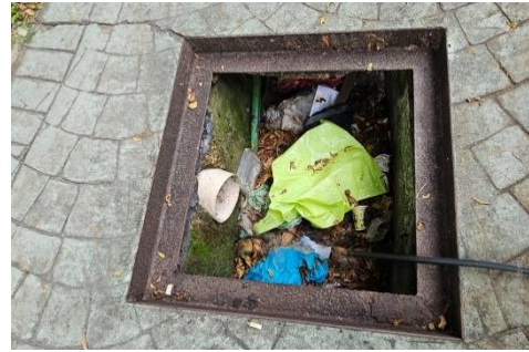
Gambar 5. Kondisi saluran drainase
