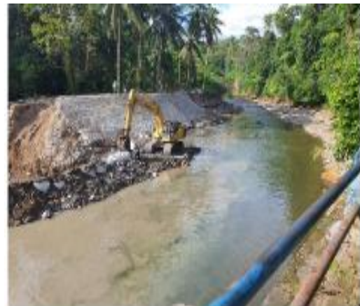
Gambar 2. Kondisi Penampang Eksisting Sungai Batang Mangor
