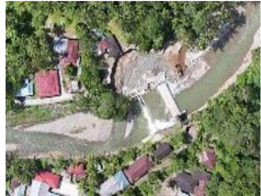
Gambar 1. Kerusakan yang terjadi di sayap kanan bendung
