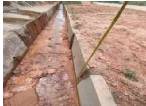
Gambar 2. Saluran u-ditch Sumber: (Survey Lapangan)
